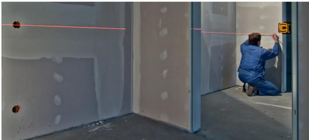
▲ Lavorare velocemente grazie al posizionamento facilitato: sul pavimento, sul treppiede, su supporti e guide in ferro con magneti in terre rare e scanalatura a "V".
